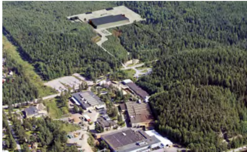
Uuden tehtaan kokonaisala on 9200 neliometriä, joista 6600 on lämmintä tilaa. Uusi tehdas kuvan yläosassa.
