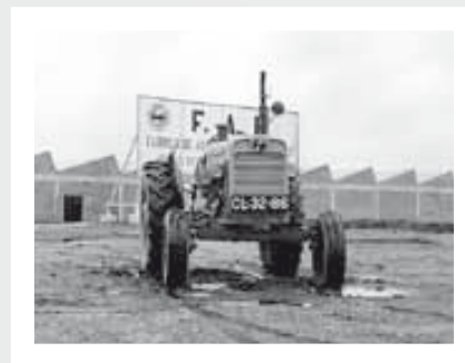
Tehdas rakennettiin Aveiron kaupunkiin lähelle Porto. Traktoria koottiin yli 700 kappaletta Portugalin markkinoille.
