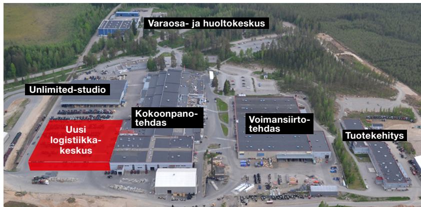
Uusi 8000 neliön logistiikkakeskus rakennetaan nykyisen kokoonpanotehtaan ja Unlimited-studion rajaamalle alueelle.
