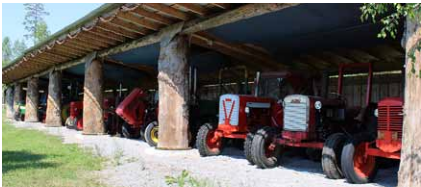
36 metriä leveän konekatoksen pystypilarit on tehty ylipaksuista pölkkyistä. Konerivistöstä löytyy Valmetejä, Zetoreita, Volvo, Fahr, Major, McCormick ja David Brown.
